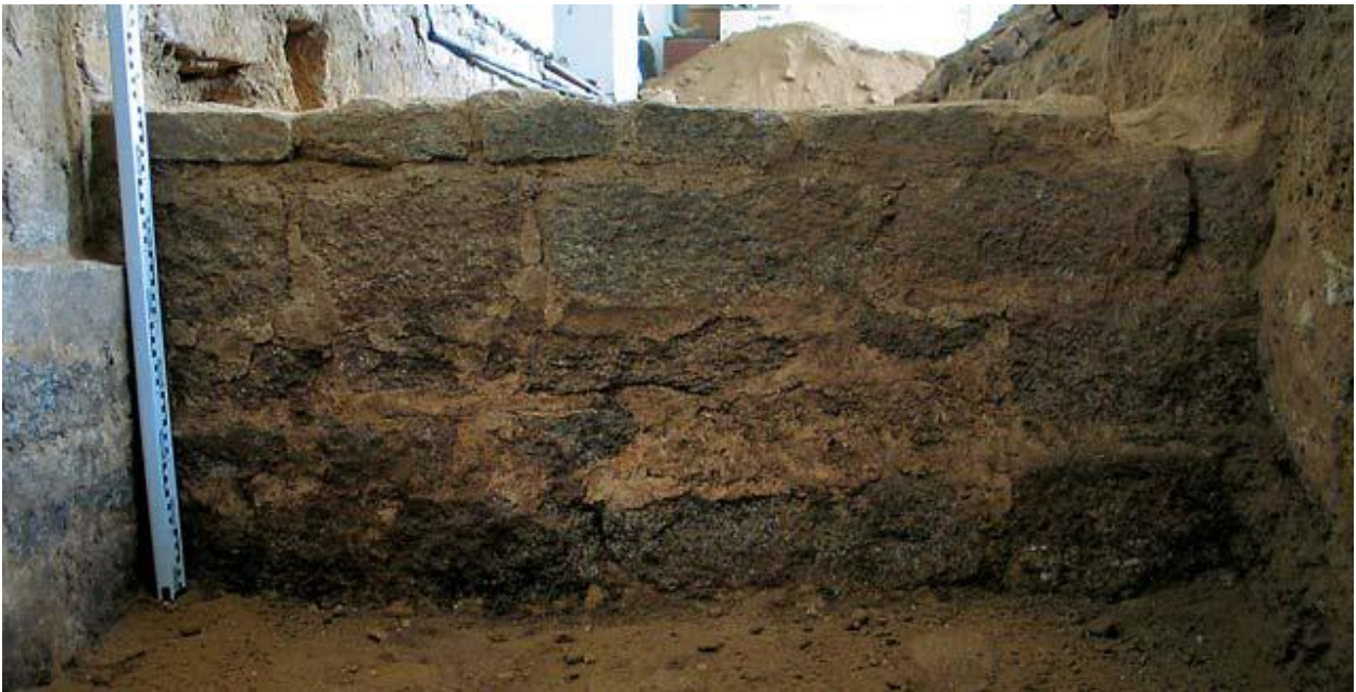
Ryc. 8. Widok na odsłonięte lico muru poprzecznego (tzw. Sala Rycerska). Fot. K. Stala
