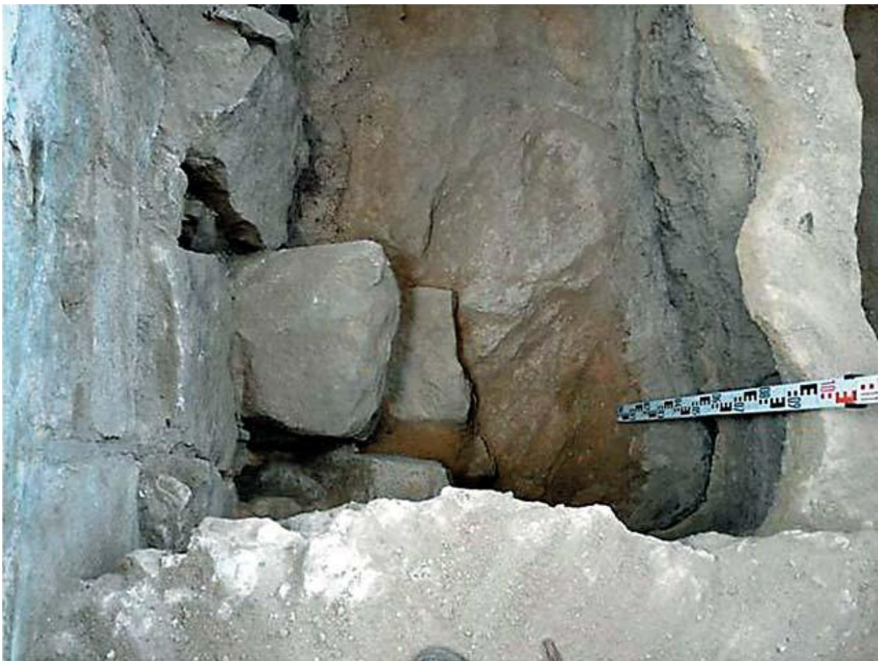
Ryc. 6. Relikt fundamentu ściany poprzecznej w prezbiterium. Fot. Cz. Hadamik
