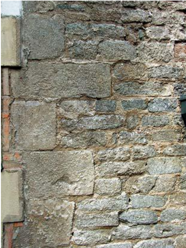
Ryc. 10. Zewnętrzny narożnik południowo-zachodni budowli romańskiej zachowany w południowej elewacji zamku. Fot. K. Stala
