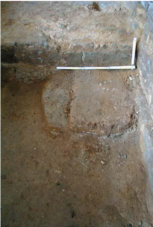
Ryc. 9. Pierwotny poziom użytkowy (w postaci fragmentarycznie zachowanej wylewki wapiennej) zarejestrowany w tzw. Sali Rycerskiej. Fot. K. Stala
